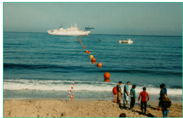
Figura 9 Posa per l'approdo di un cavo sottomarino.
