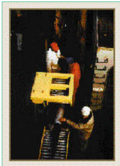
Figura 11 Operazione di posa di un ripetitore.
