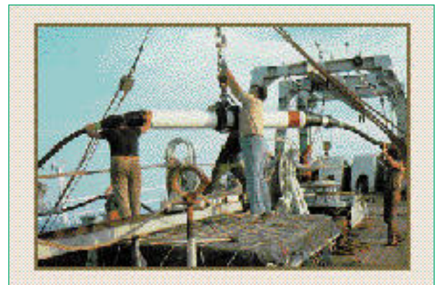
Figura 4 Posa di un contenitore a siluro per ripetitori (1960-1970).
